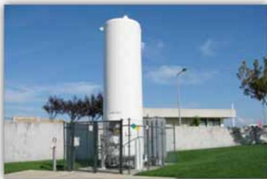
Figura 7: Armazenamento de gases medicinais criogénicos, acondicionados em reservatórios.
