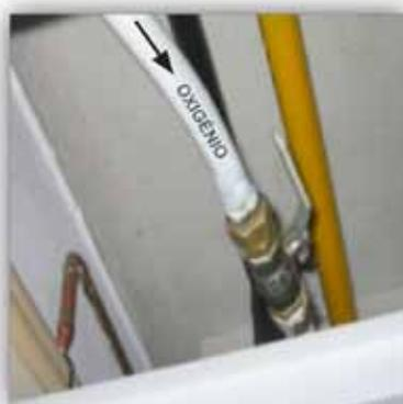
**Figura 17:** Exemplo de tubagem, com marcação e código de cores, e respectiva válvula de corte para o Oxigénio medicinal.
