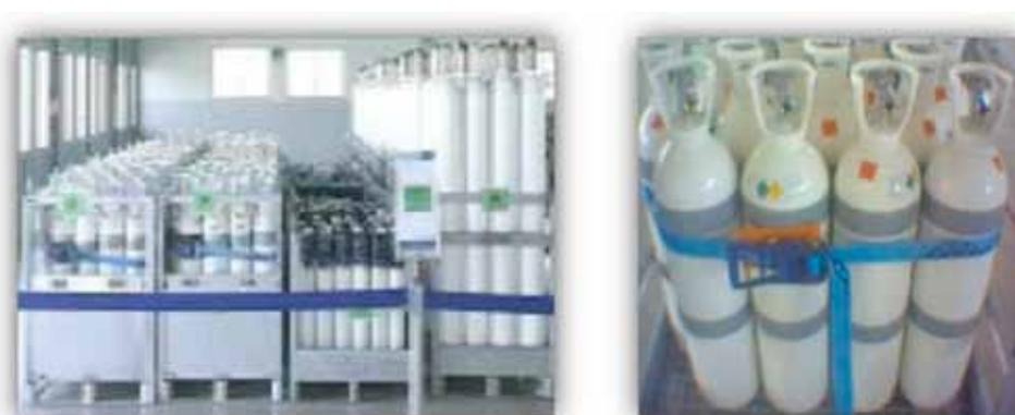
**Figura 6:** Armazenamento de gases medicinais, acondicionados em cilindros.
