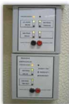
Figura 11: Painel de alarme dos gases medicinais
