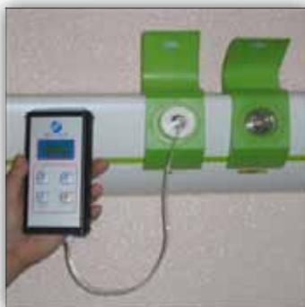
**Figura 19:** Controlo analítico de rotina, numa unidade terminal de um serviço clínico, em que se analisa a pureza e pressão do de um gás medicinal (controlo analítico não especificado na FP).
